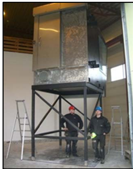
Da var krancabinen trygt på plass på pidestallen. Et mektig syn når vi tar et par steg tilbake for å betrakte det hele. Nå starter monteringen av selv kula / doomen som skal omringe selve krancabinen.
