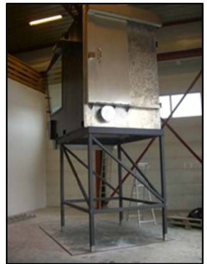
Da var krancabinen trygt på plass på pidestallen. Et mektig syn når vi tar et par steg tilbake for å betrakte det hele. Nå starter monteringen av selv kula / doomen som skal omringe selve krancabinen.
