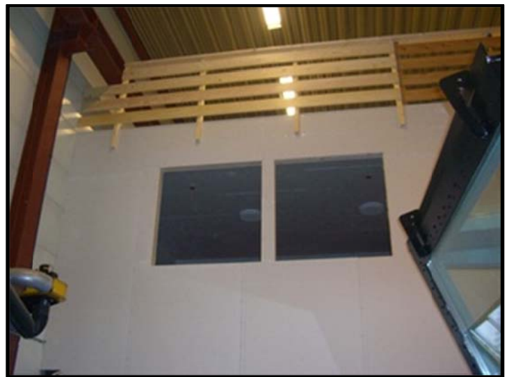
Vindu til kontrollrom sett fra utsiden.
