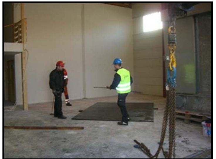
Finjustering og riktig plassering av stålplate.
