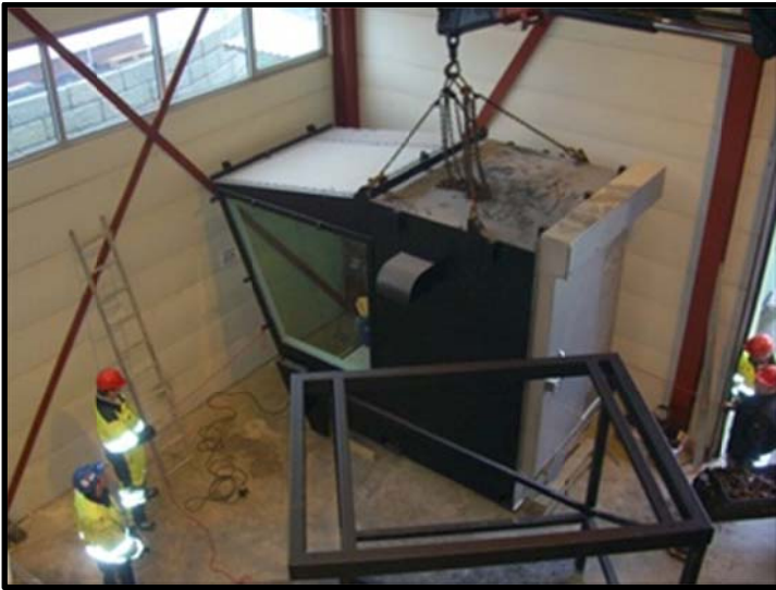
Krancabinen klargjøres for løfting og montering på pidestall.
