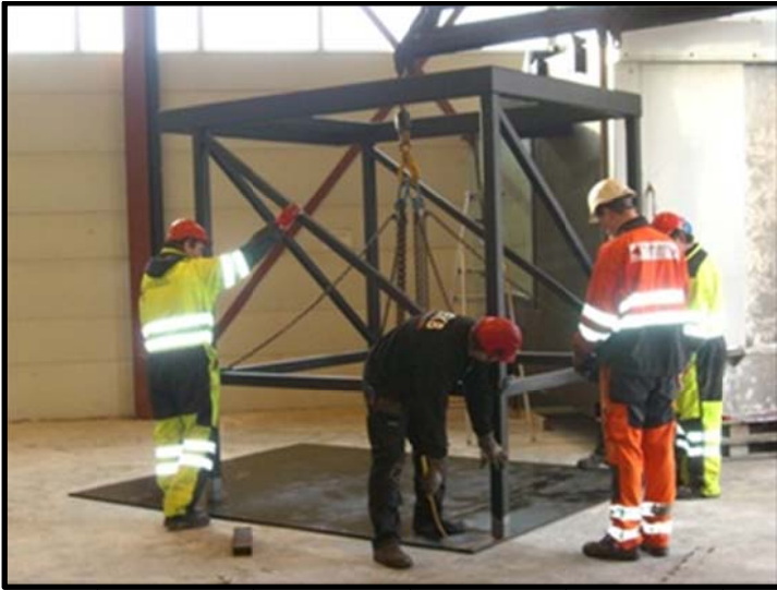
Krancabin fundamentet / pidestallen blir heist på plass
