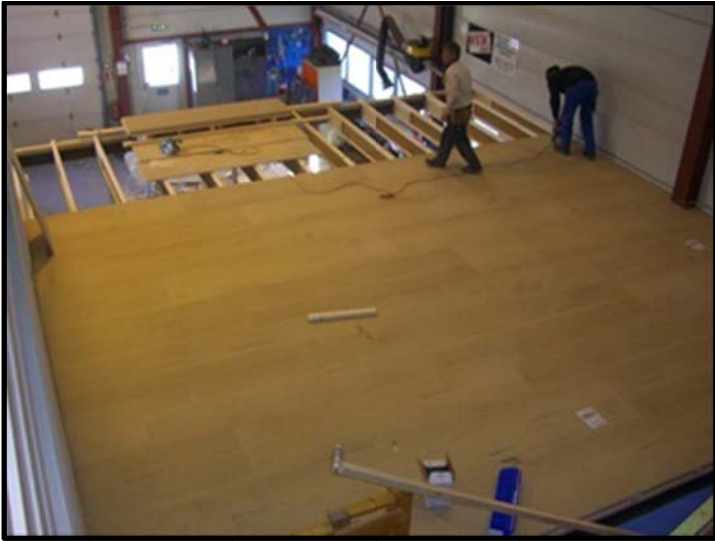
Gulv til kontrollrom og anhuker/signalgiver stasjonene begynner å ta form
